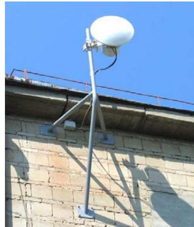
Чтобы предотвратить соскальзывание корпуса приемопередатчика вниз по опоре, - при наведении антенн, пока крепление подвеса к опоре не затянуто, - временно используйте хомут (автомобильный хомут) подходящего диаметра. Для этого затяните хомут под механизмом крепления перед тем, как ослабить винты крепления подвеса (хомут не входит в комплект поставки).
